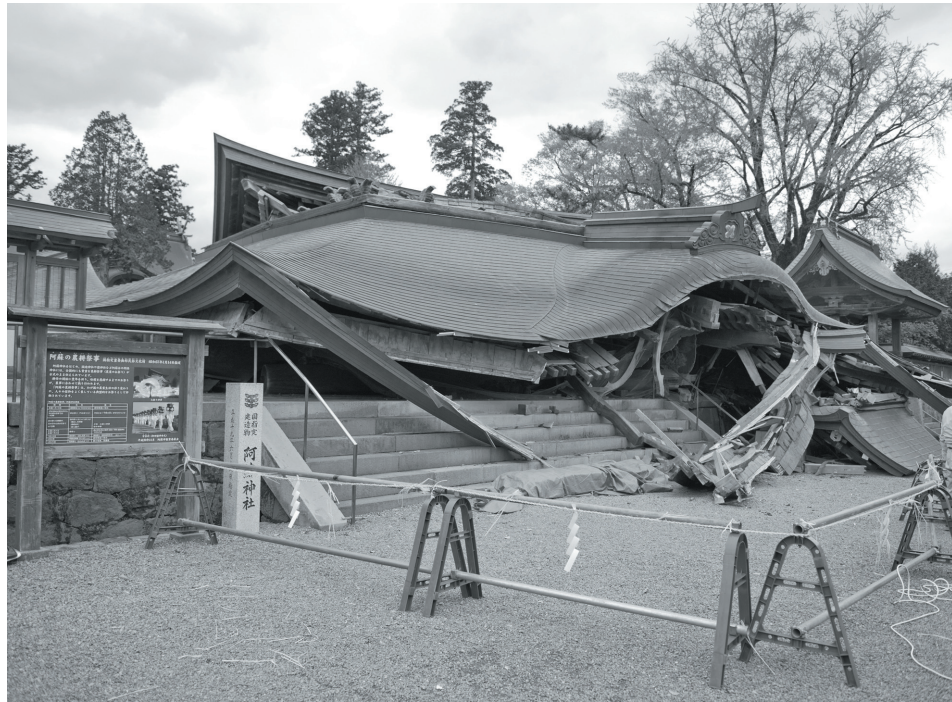
写真 1:倒壊した阿蘇神社楼門 (平成 28 年 4 月 18 日撮影)
