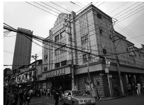
図1 「SNH48 星夢劇場」の外観（筆者撮影）。劇場の周囲は下町の雰囲気が残る低層の住宅と高層マンションが混在する地域である。
