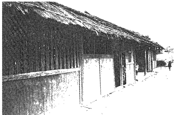
図6 同じく東田小学の教室を外側から。
